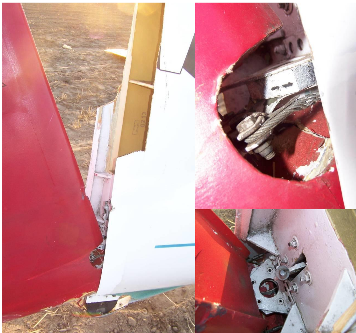
20, 21, 22 – Dolny zawias steru kierunku – zbliżenia. Widoczna dźwignia napędu i linki steru kierunku.
