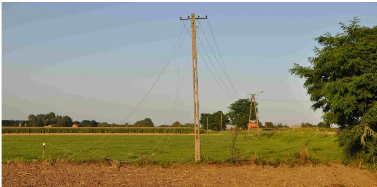
10 – Widok od strony linii podejścia na słup „P” linii energetycznej, znajdujący się na prawo od trajektorii lądowania i na zerwane przez lądujący szybowiec przewody.
